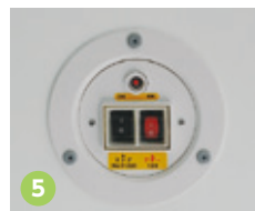
5 非常警報装置
